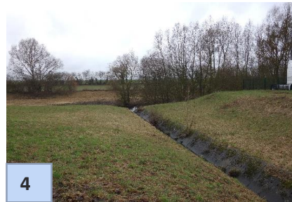
Bassin de rétention raccordé au Fossé des Noues
